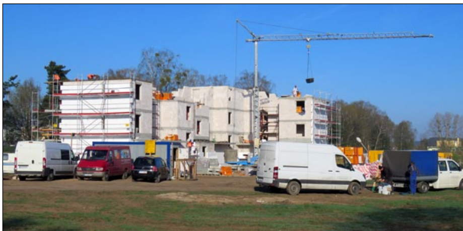
Budynek komunalny przy al. Wolności
