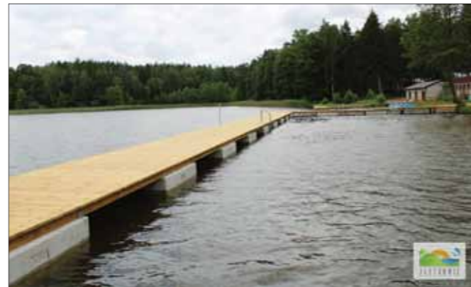
Tzw. ósemka tuż przed montażem lin zabezpieczających, w tle pomost cumowniczy
