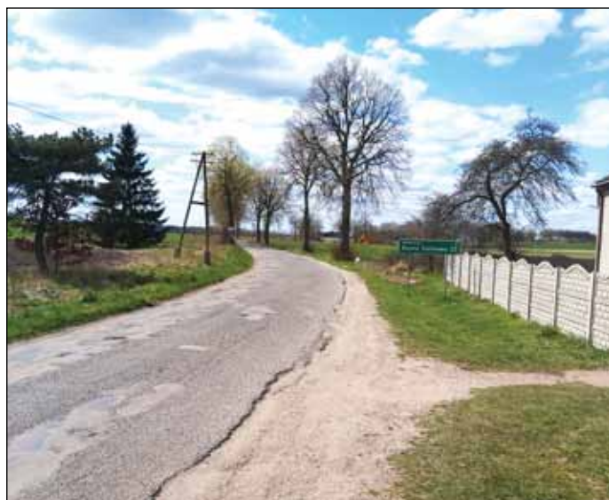
Jednym z elementów projektu jest m. in. ułożenie chodnika wzdłuż całej miejscowości Sypniewo aż do Nadarzyce
