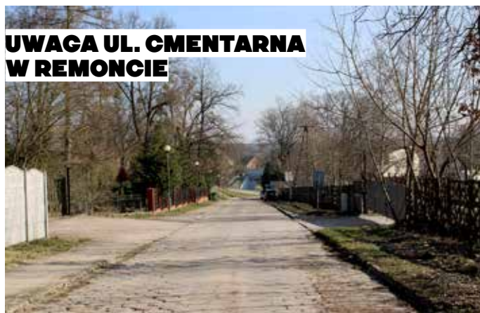
Kwota ok 1 mln zł jest przeznaczona na remont ul. Cmentarnej
