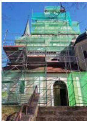
Kościół pw. Św. M. Archanioła w Jastrowiu już w remoncie
