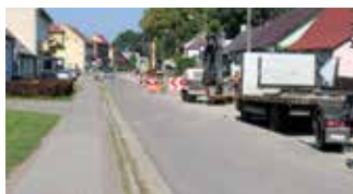
Etapy budowy kanalizacji w Sypniewie
