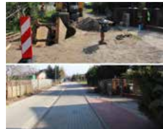
Ulica Boczna w trakcie i po inwestycji
